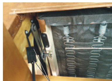
Connecteurs du transformateur électrique du refroidisseur thermoélectrique
