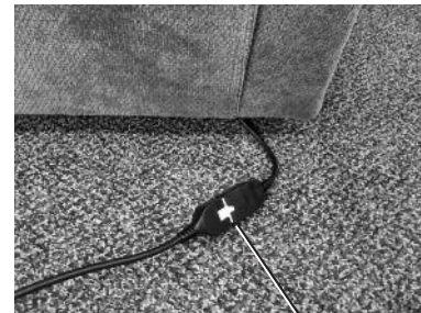
Conexión del transformador de energía
